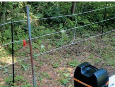
図33 各ラインを縦につなぐ縦結索を数か所(できれば各面に一ヵ所ずつ)実施することが望ましい。またパワーユニットは必ず電気柵の内側に設置することにより、クマによるいたずらや、盗難被害を避けられる
