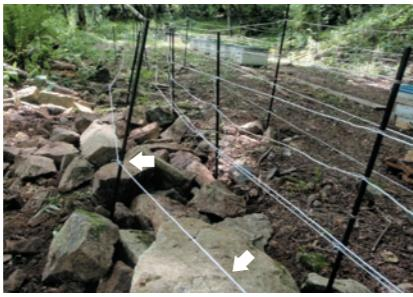
図19 外柵のライン下の岩礫を掘って侵入されたあと、埋め戻してその上にラインを追加した例(図中矢印)
