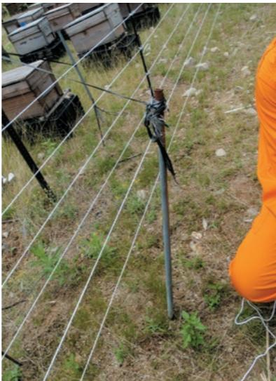
図21 金属製のポール(支柱)が隣接していると、強風などでラインが接触した時に漏電がおきるので、不要なポールはすべて撤去しておくことが望ましい
