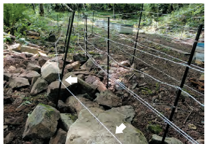
図21 外柵のライン下の岩礫を掘って侵入されたあと、埋め戻してその上にラインを追加した例(図中矢印)
