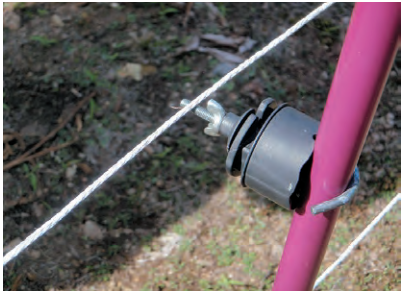
図24 碍子の金属部分にラインがふれている例。特に雨でボールが濡れていると、表面を通じて漏電が起きる
