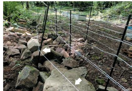
図21 外柵のライン下の岩礫を掘って侵入されたあと、埋め戻してその上にラインを追加した例(図中矢印)
