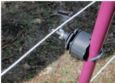
図24 碓子の金属部分にラインがふれている例。特に雨でポールが濡れていると、表面を通じて漏電が起きる
